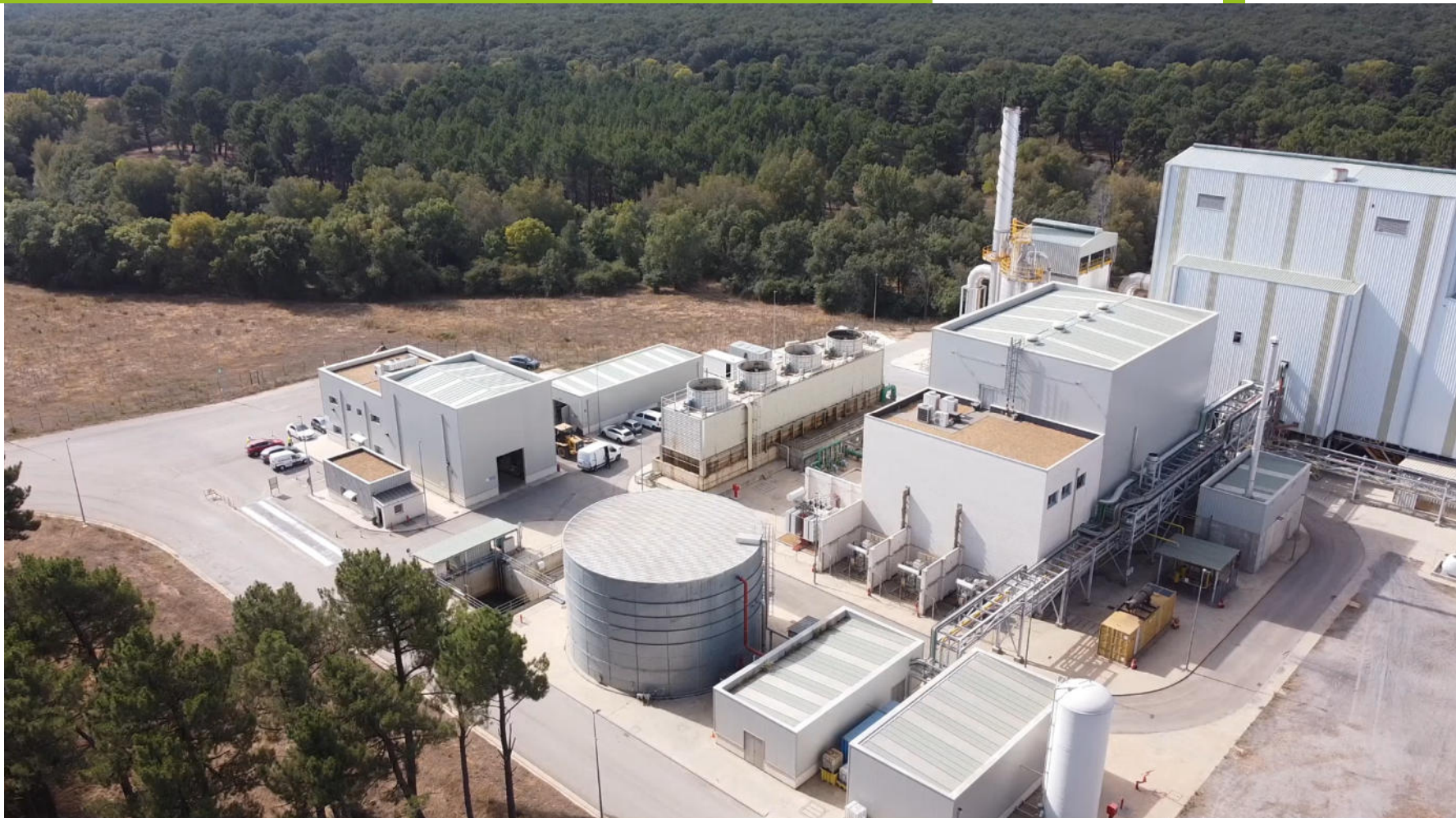
17 MWe. Central de Biomasa en Garray, Soria
